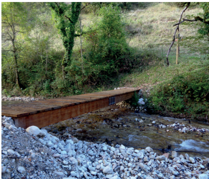
Guado pedonale sul fiume Tenna (ph Toni Galdi)
