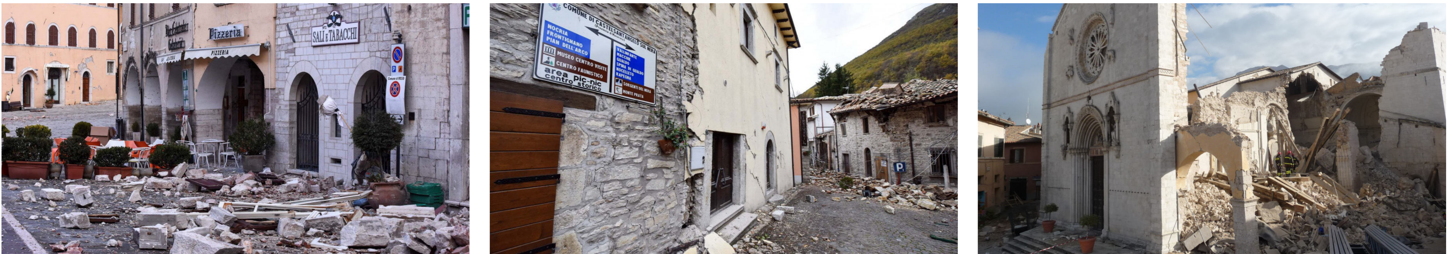
Alcuni danni a Visso (sinistra), Castelsantangelo sul Nera (centro) e Norcia (destra) dovuti al terremoto del 30 Ottobre 2016. Some damages at Visso (left), Castelsantangelo sul Nera (center) and Norcia (right), due to the 2016 October 30 main shock.
