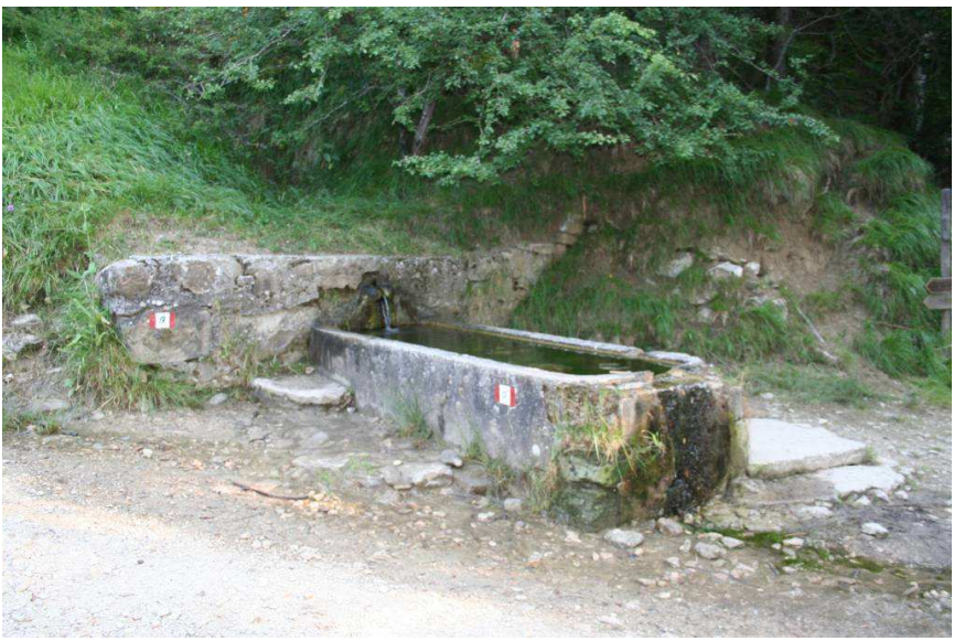
Fontanile di Sorg.te Santa
