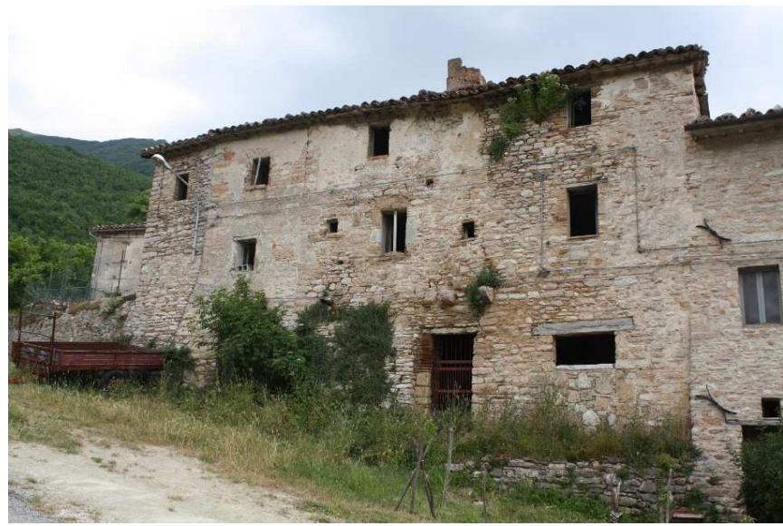
Rudere in località Meriggio
