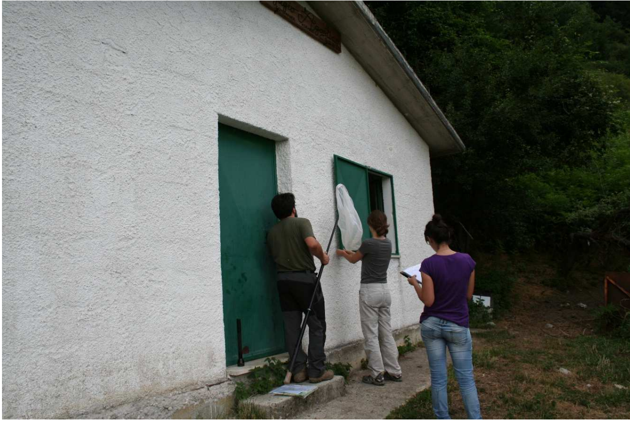
Ispezione del Rifugio Agostino
